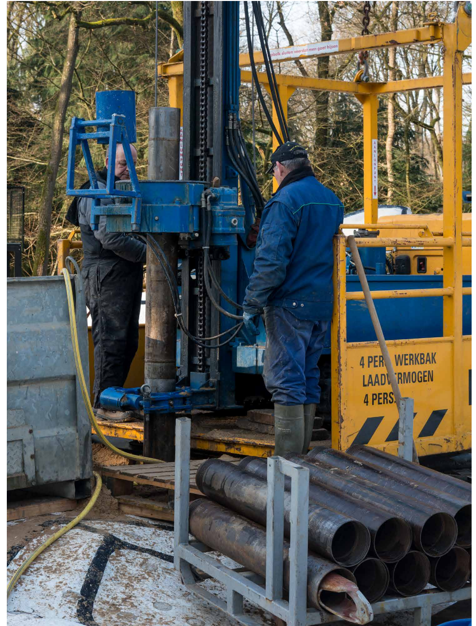
Uitvoeren van de 40 meter diepe bronboringen door Van Tongeren BV, november 2016
